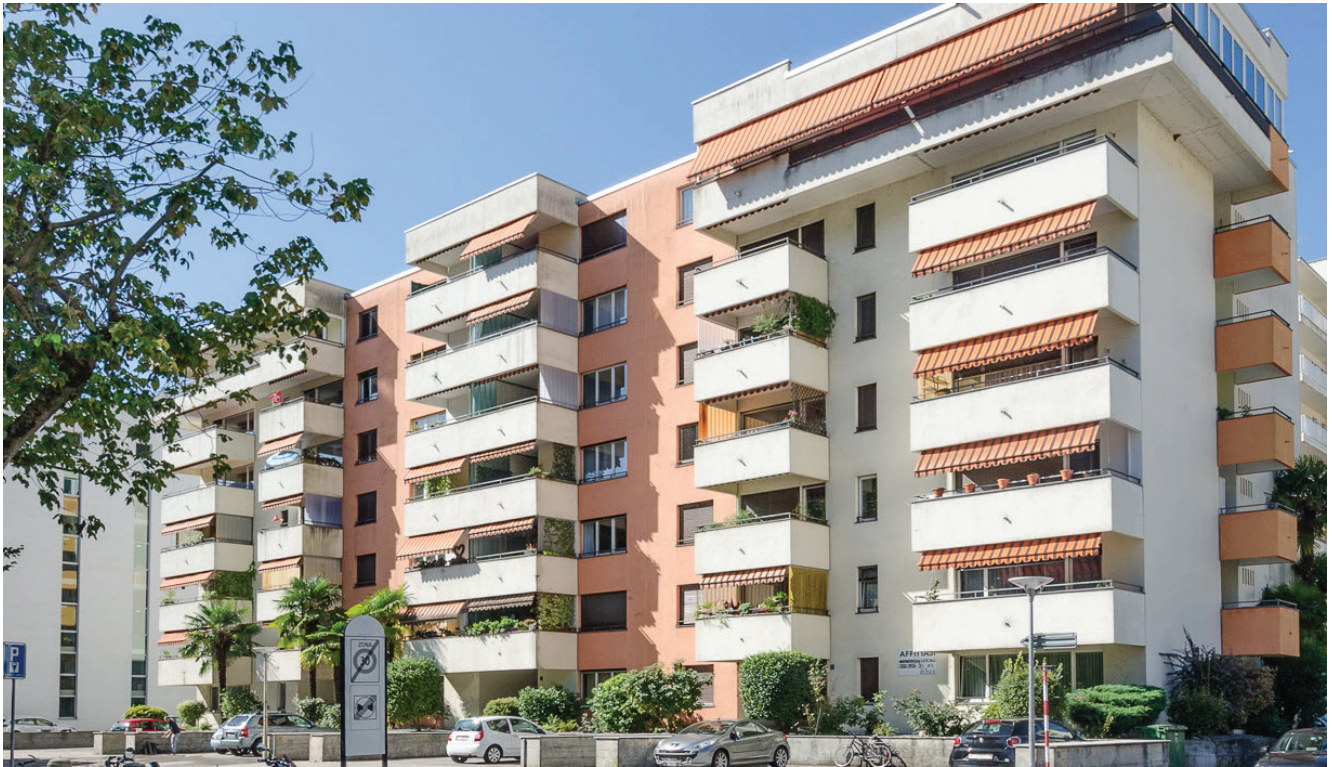
Locarno, Via della Pace 20
